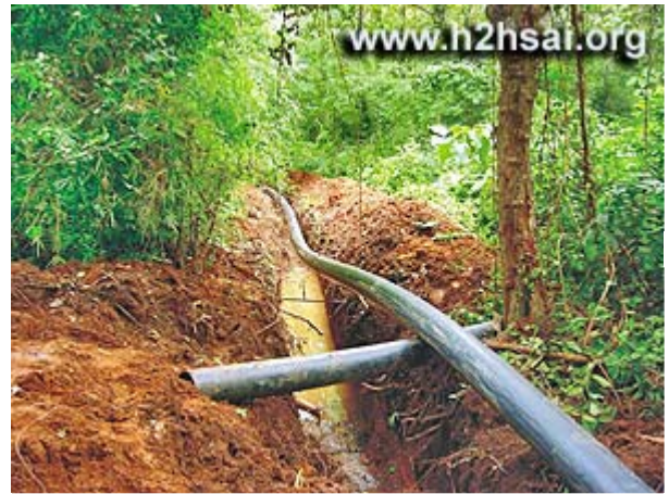
...Sie mussten durch Wälder und über Hügel verlegt werden.
