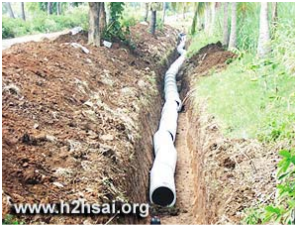
Hunderte Kilometer Rohrleitungen wurden gelegt...
